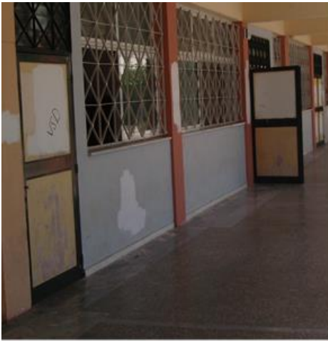
Άποψη υφισταμένων θυρών αιθουσών διδασκαλίας
