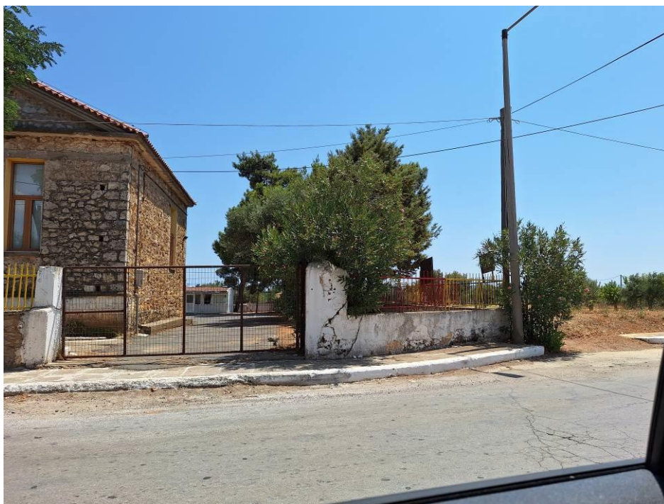
Άποψη του βόρειου τμήματος περιτοίχισης του σχολείου
