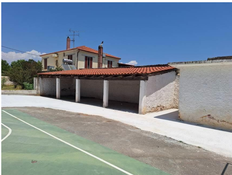
Άποψη του χαμηλού υποστέγου στο δυτικό όριο του οικοπέδου
