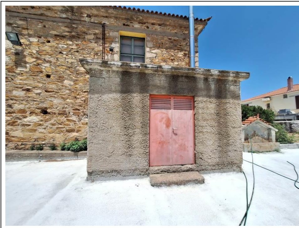
Άποψη του εξωτερικού του οικίσκου του λεβητοστασίου στην νότια όψη του σχολείου
