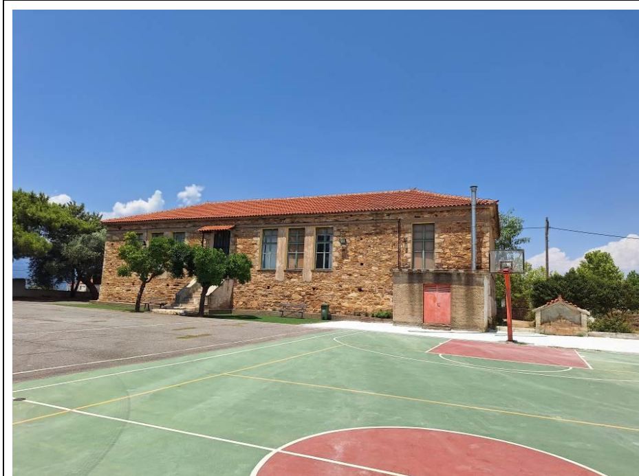
Νότια όψη του κτιρίου του Δημοτικού Σχολείου (οπίσθια όψη σχολείου)
