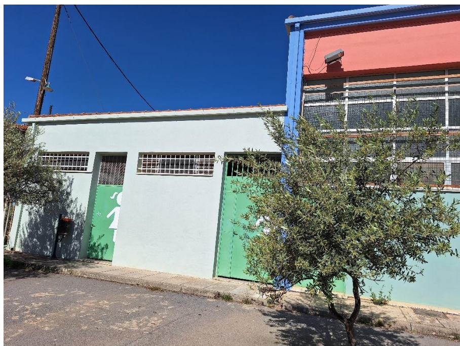
Εξωτερική άποψη του κτιρίου WC αυλής και τμήματος του κτιρίου του Γυμναστηρίου
