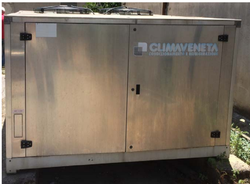
Εικόνα 3.1 Ο υφιστάμενος αερόψυκτος ψύκτης (CLIMAVENETA) των χειρουργείων του κτιρίου ΚΤ4
