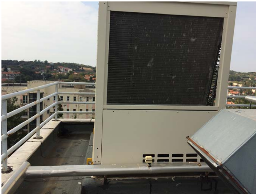
Εικόνα 3.3 Ο υφιστάμενος αερόψυκτος ψύκτης (HITACHI) του κτιρίου ΚΤ5α
