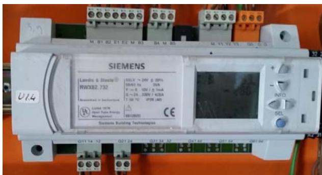
Εικόνα 5.1 Μονάδες ελέγχου ΚΚΜ Χειρουργείου (Αριστερά) - ΚΚΜ U1.4 (δεξιά)
