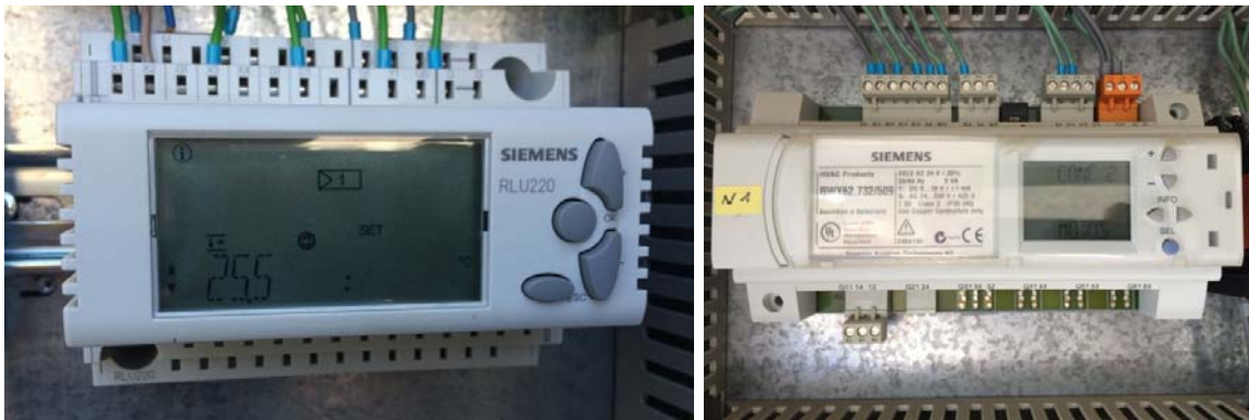
Εικόνα 5.2 Μονάδες ελέγχου ΚΚΜ κυρίως χώρου (Αριστερά) - ΚΚΜ Νο1 (δεξιά)
