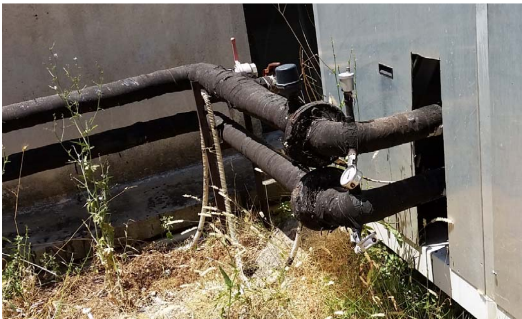
Εικόνα 3.2 Δίκτυο σωληνώσεων από τον αερόψυκτο ψύκτη προς το μηχανοστάσιο της ΚΚΜ των χειρουργείων του κτιρίου ΚΤ4
