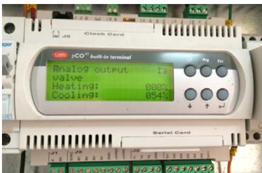
Εικόνα 5.1 Μονάδες ελέγχου ΚΚΜ Χειρουργείου (Αριστερά) - ΚΚΜ U1.4 (δεξιά)
