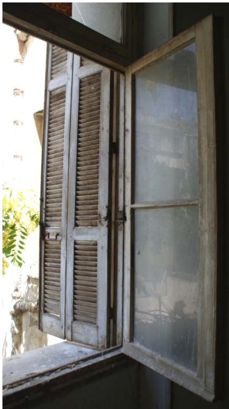
Εικόνα 78. Παράθυρο γαλλικού τύπου με ανοιγόμενα τζαμιλίκια, ανακλινόμενους φεγγίτες και εξώφυλλα.
