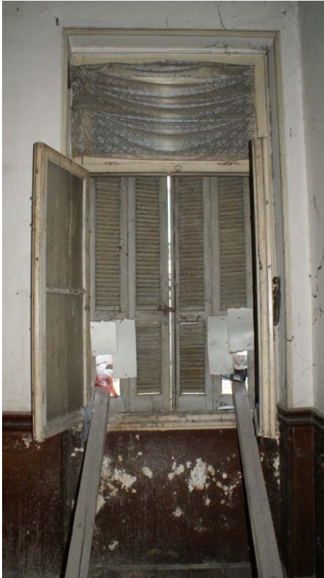
Εικόνα 76. Παράθυρο γαλλικού τύπου με ανοιγόμενα τζαμιλίκια, ανακλινόμενους φεγγίτες και εξώφυλλα.
