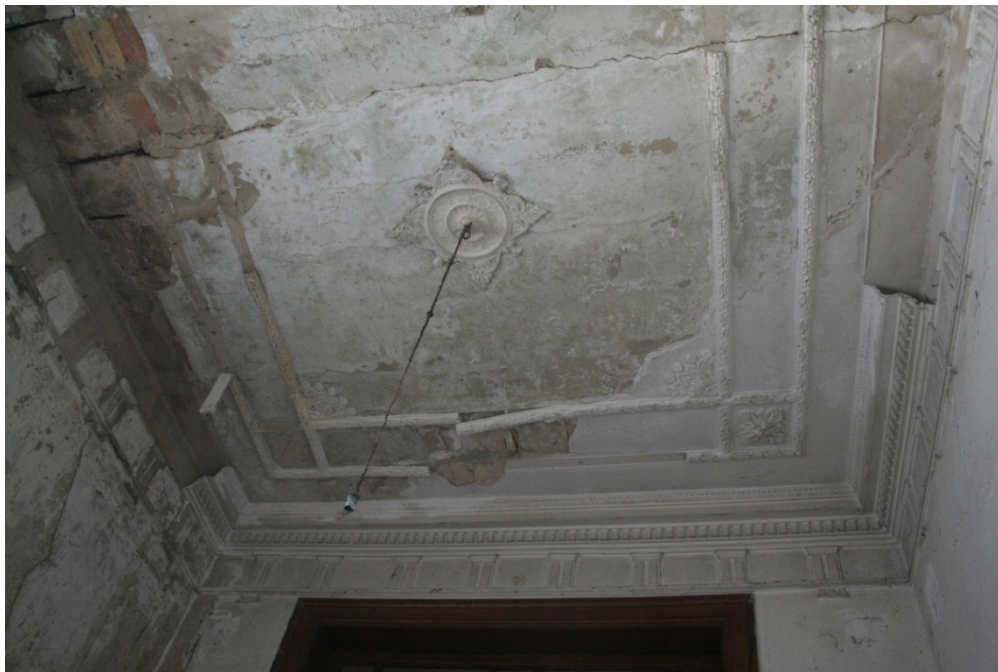
Εικόνα 546. Άποψη οροφής χώρου Β.4 με εκτεταμένες φθορές που έχουν επηρεάσει άμεσα και έμμεσα τις τοιχογραφημένες επιφάνειες.
