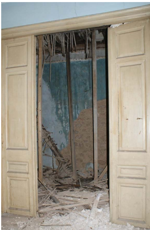
Εικόνα 89. Ξύλινη τετράφυλλη ταμπλαδωτή θύρα.
