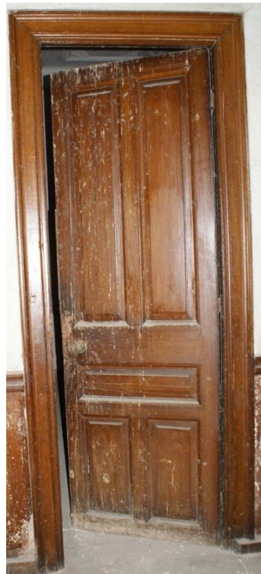
Εικόνα 86. Ξύλινη Ταμπλαδωτή Θύρα.
