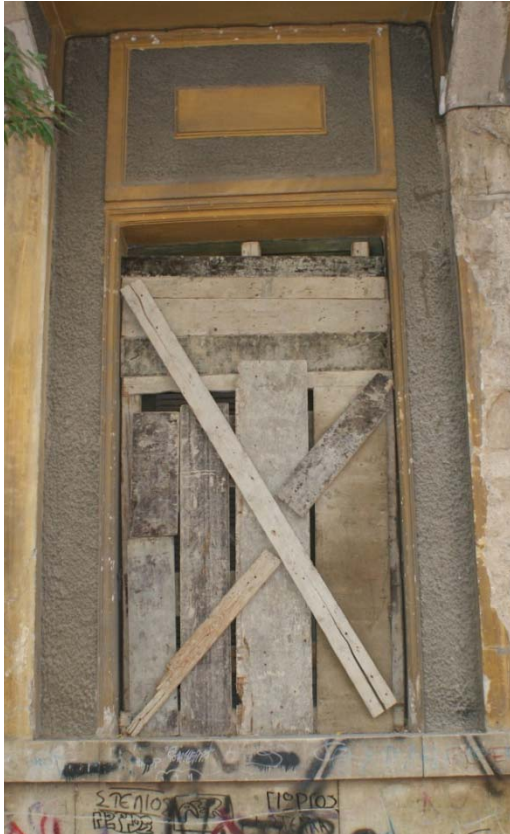
Εικόνα 80. Άνοιγμα επί της οδού Μιχ.Βόδα
