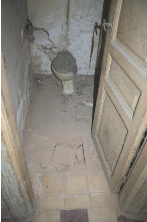
Εικόνα 171. Εκτεταμένες θραύσεις στα πλακίδια του λουτρού στην ισόγεια στάθμη.
