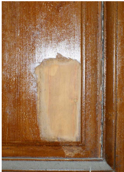
Εικόνα 91. Διερευνητική τομή σε εσωτερική ξύλινη θύρα καφέ χρώματος
