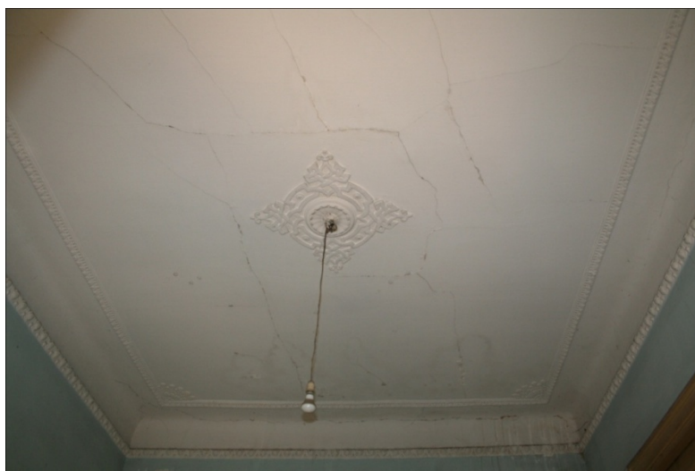
Εικόνα 7309. Ισόγεια στάθμη - Χώρος ΙΣ.8.
