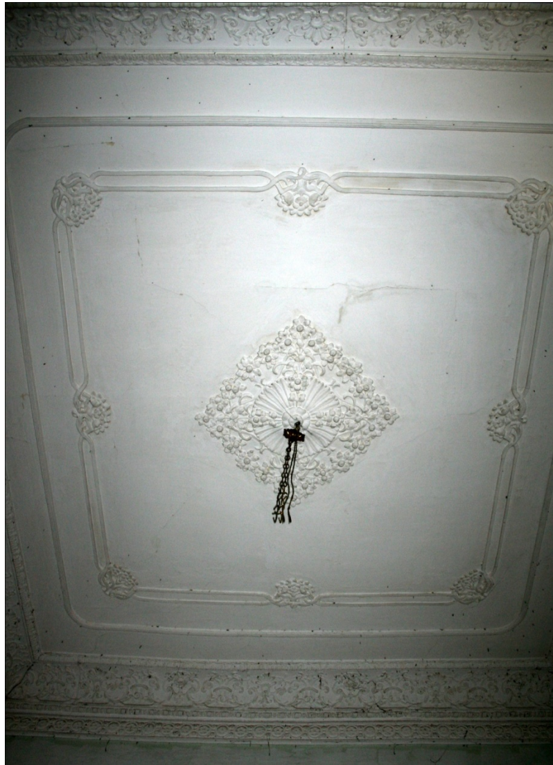
Εικόνα 105. Ισόγεια στάθμη - Χώρος ΙΣ.4.
