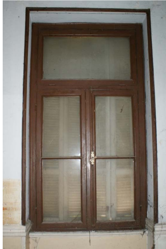
Εικόνα 77. Εσωτερική άποψη κουφώματος.
