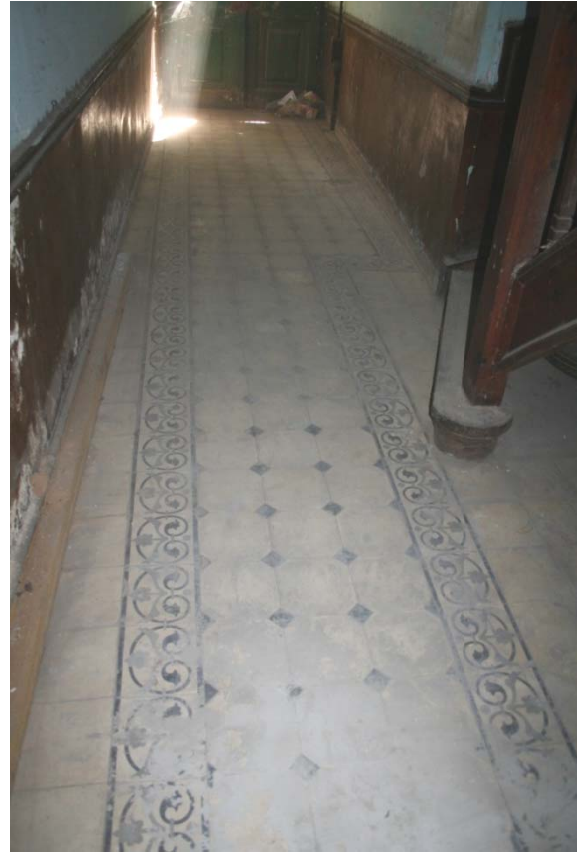
Εικόνα 141. Ισόγεια στάθμη - Χώρος ΙΣ.5.
