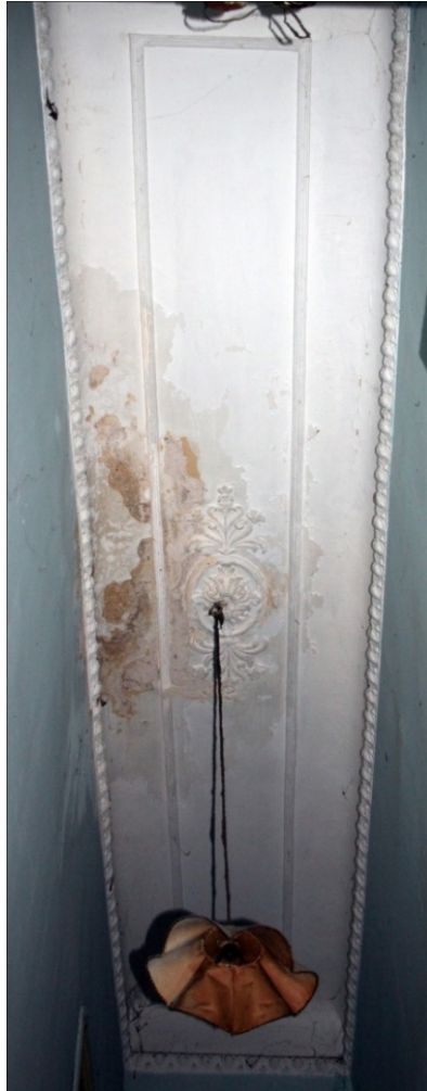
Εικόνα 110. Ισόγεια στάθμη - Χώρος ΙΣ.9.
