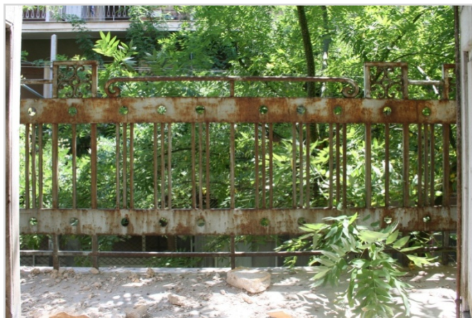
Εικόνα 173,174. Προστατευτικά σιδηρά κιγκλιδώματα στους εξώστες των ορόφων.
