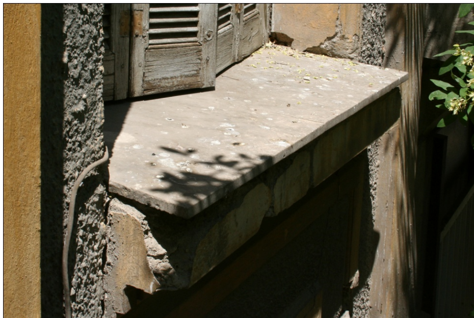
Εικόνα 191. Καλυπτήρια πλάκα μαρμάρου στο γείσο παραθύρου του β' ορόφου στην ανατολική όψη.
