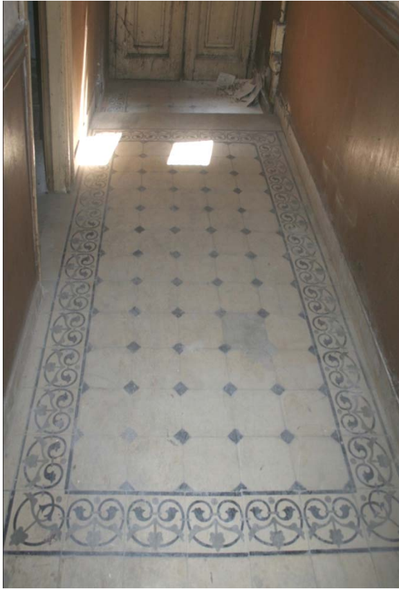
Εικόνα 140. Ισόγεια στάθμη - Χώρος ΙΣ.3.
