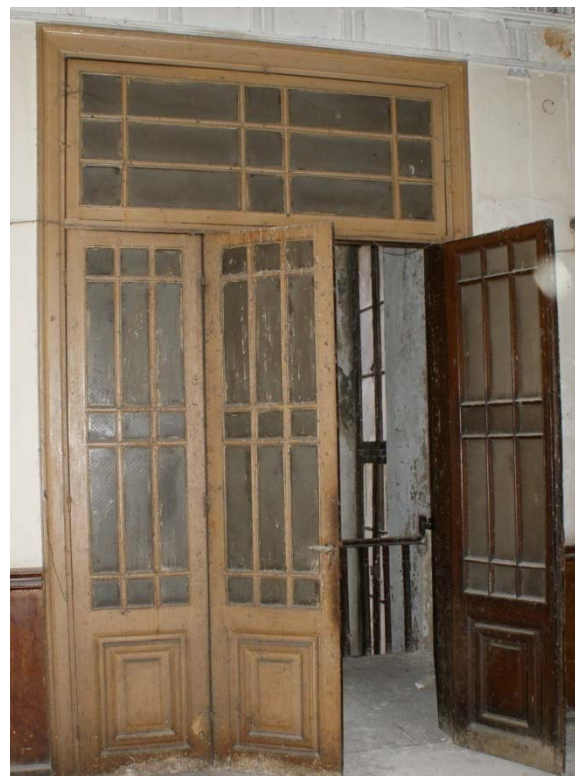
Εικόνα 90. Τζαμόπορτα με σύνθετη σχεδίαση και ταμπλά στο κάτω μέρος.
