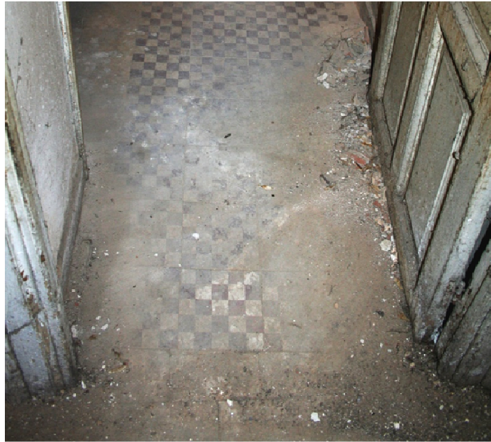
Εικόνα 166. Υπολείμματα δομικών υλικών και άλλες επικαθήσεις στα πλακίδια των δαπέδων.
