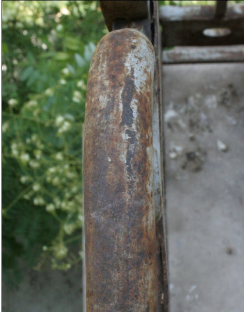
Εικόνες 189,190. Δείγματα καθαρισμού στο προστατευτικό κιγκλίδωμα του εξώστη του β' ορόφου και στη θύρα εισόδου στο χώρο ΙΣ.1 αντίστοιχα.
