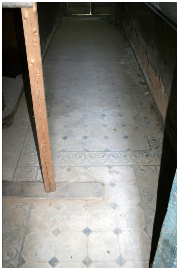
Εικόνα 139. Ισόγεια στάθμη - Χώρος ΙΣ.1.
