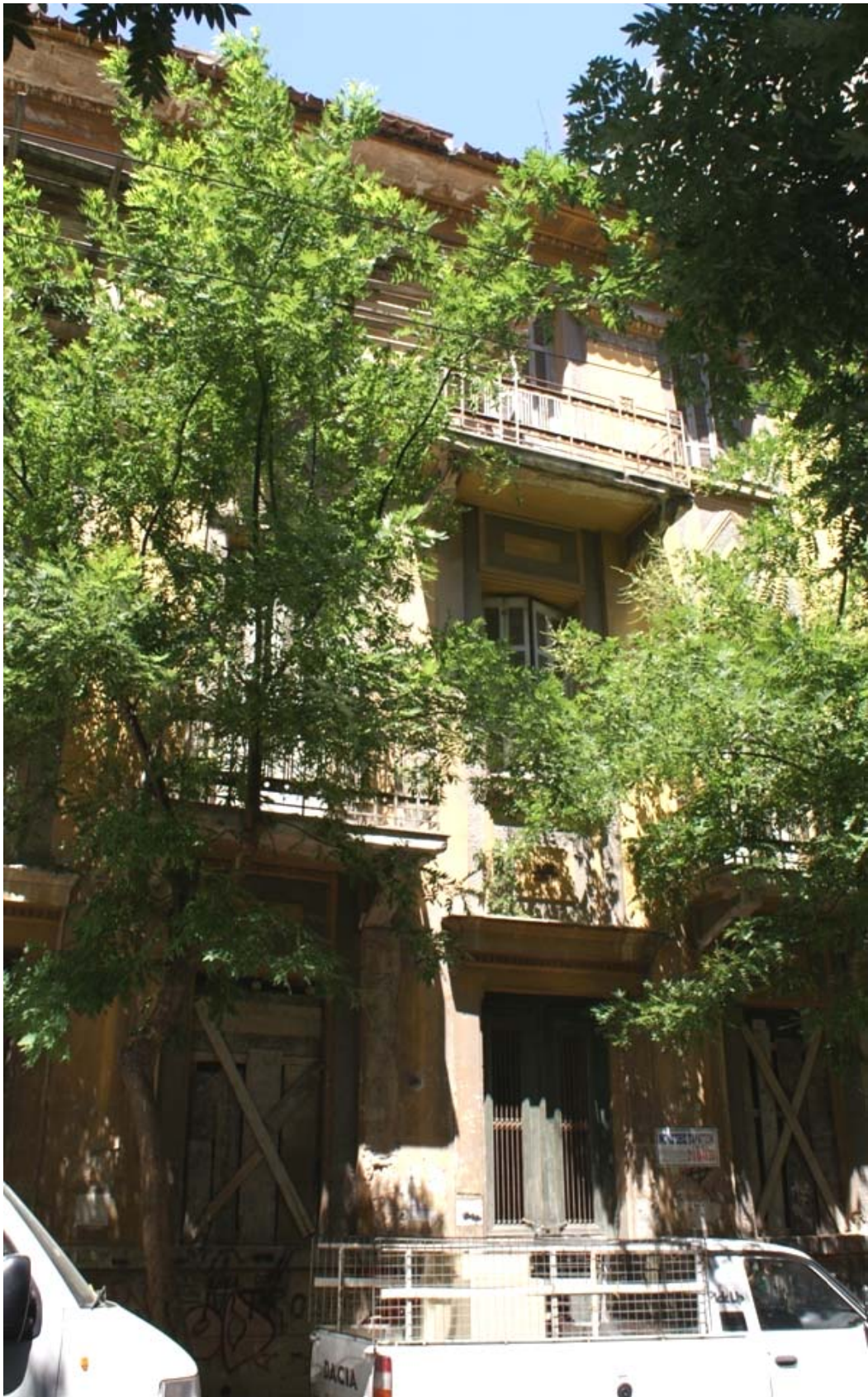
Εικόνα 2. Άποψη της ανατολικής όψης του νεοκλασικού κτηρίου.
