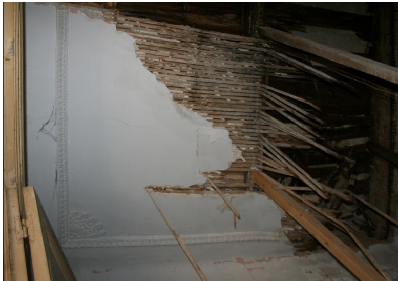
Εικόνα 108. Ισόγεια στάθμη - Χώρος ΙΣ.7.
