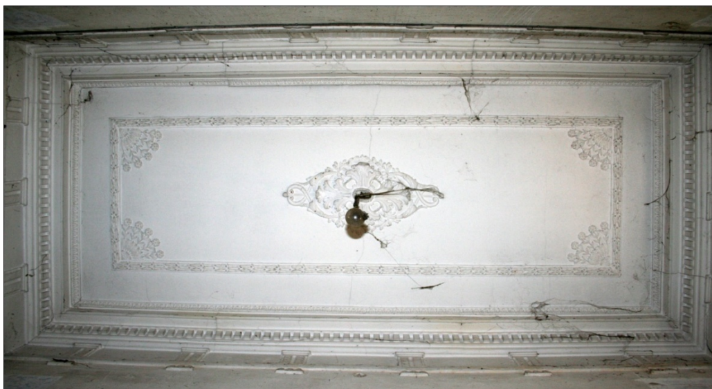
Εικόνα 102. Ισόγεια στάθμη - Χώρος ΙΣ.1.
