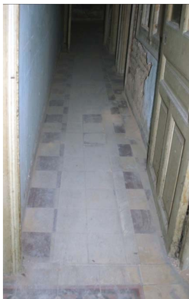
Εικόνα 146. Ισόγεια στάθμη – Χώρος ΙΣ.9.
