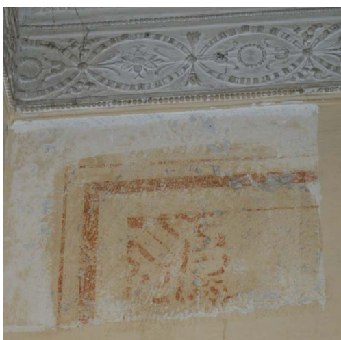
Εικόνα 37. Λεπτομέρεια ζωγραφικού διακόσμου στην περιοχή του Α.2.
