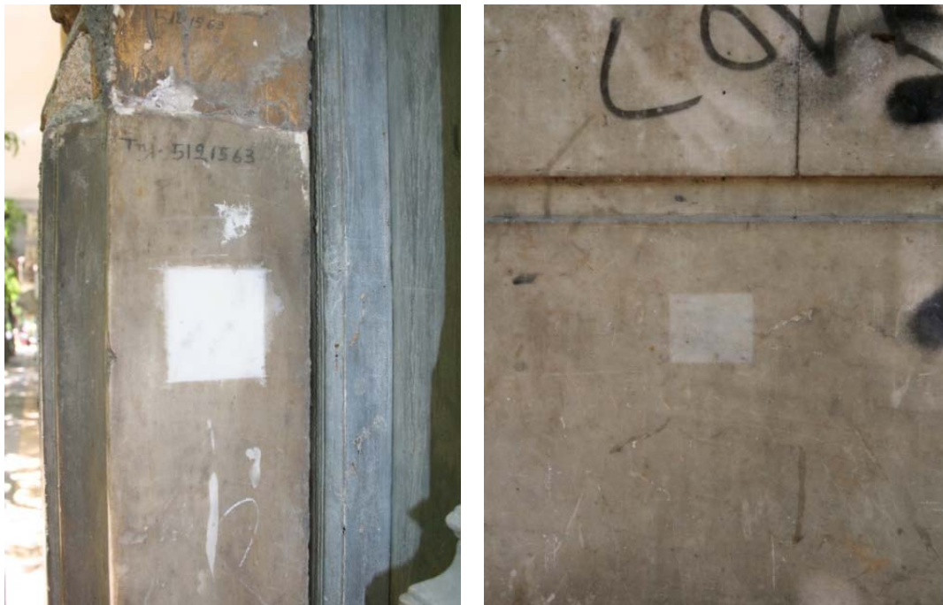
Εικόνες 204,205. Δείγματα καθαρισμού στην εσωτερική πλάγια όψη της νότιας παραστάδας της εισόδου στο χώρο ΙΣ.1, καθώς και σε δόμο της επένδυσης στην ισόγεια στάθμη αντίστοιχα.
