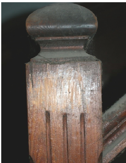
Εικόνα 71. Διερευνητική τομή σε κάθετο κολωνάκι της σκάλας.
