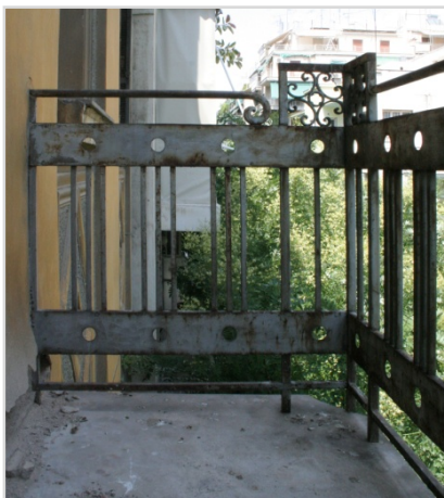
Εικόνα 173,174. Προστατευτικά σιδηρά κιγκλιδώματα στους εξώστες των ορόφων.
