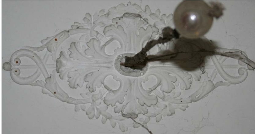
Εικόνα 131. Στίγματα σκουριάς από τις μεταλλικές καρφίδες ανάρτησης.
