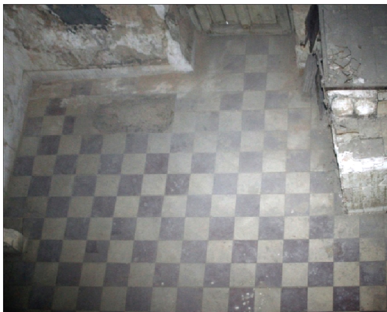
Εικόνα 147. Ισόγεια στάθμη – Χώρος ΙΣ.12
