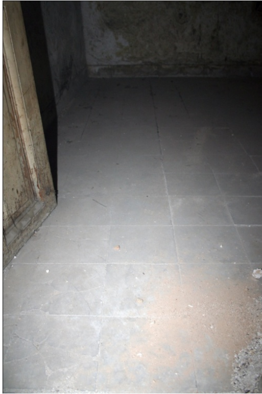
Εικόνα 151. Ισόγεια στάθμη - Χώρος ΙΣ.13.
