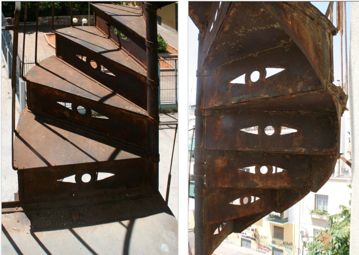
Εικόνες 186,187. Το εξωτερικό κλιμακοστάσιο (σκάλα υπηρεσίας) στη δυτική όψη του κτηρίου, λεπτομέρειες.
