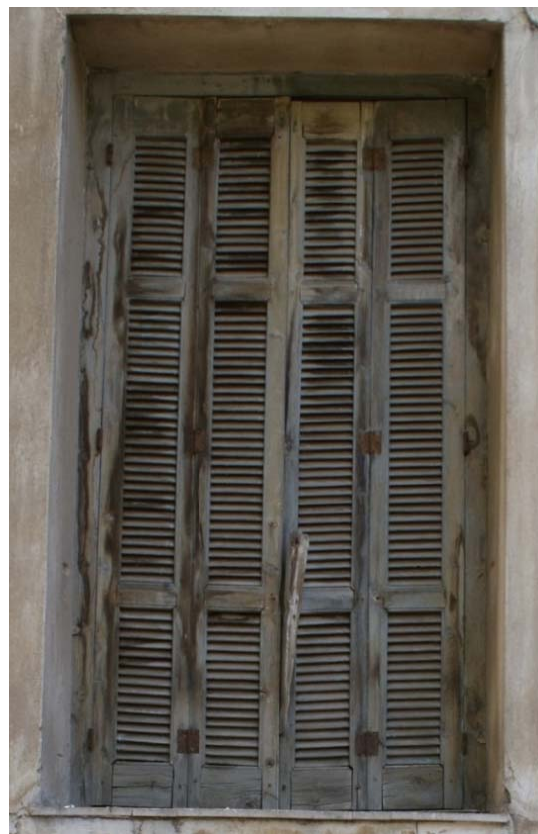
Εικόνα 79. Ξύλινο πατζούρι γαλλικού τύπου.
