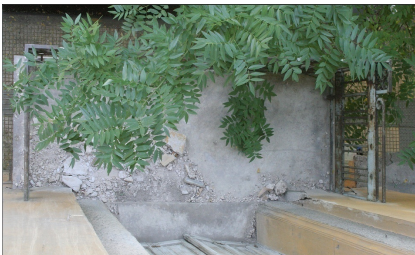
Εικόνα 200. Η άνω λειτουργική επιφάνεια του νότιου εξώστη του α' ορόφου στην ανατολική κύρια όψη του κτηρίου.
