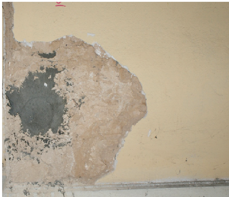
Εικόνα 39. Μερική απώλεια του κονιάματος και τμηματική μεταγενέστερη συμπλήρωσή του με τσιμεντοκονίμα στον χώρο Α.3.
