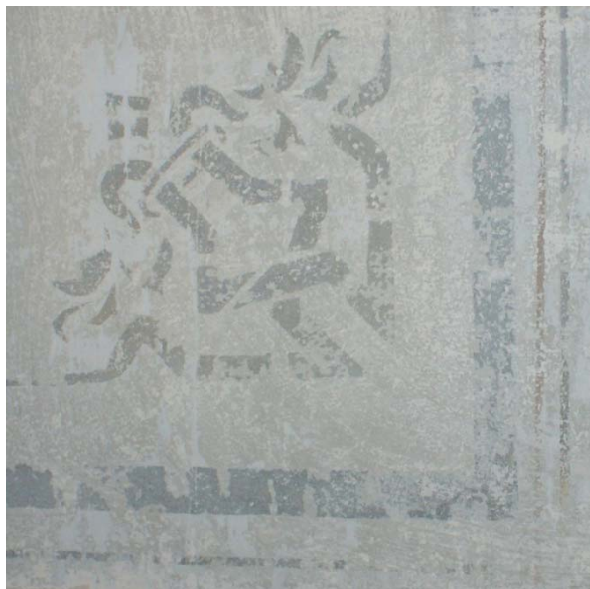
Εικόνα 44. Αποκάλυψη ζωγραφικού διακόσμου μετά τη διερευνητική τομή στον χώρο του κλιμακοστασίου του α' ορόφου.
