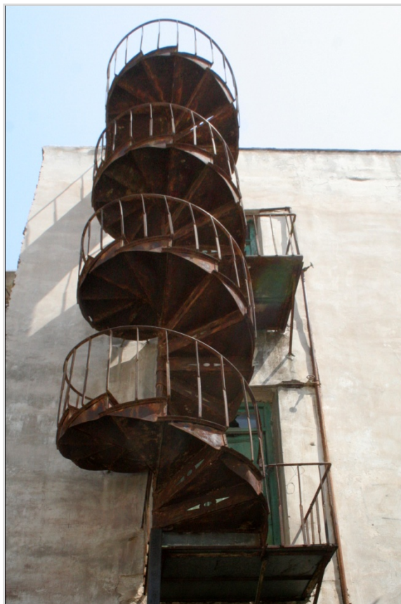
Εικόνα 179. Το εξωτερικό κλιμακοστάσιο (σκάλα υπηρεσίας) στη δυτική όψη του κτηρίου.
