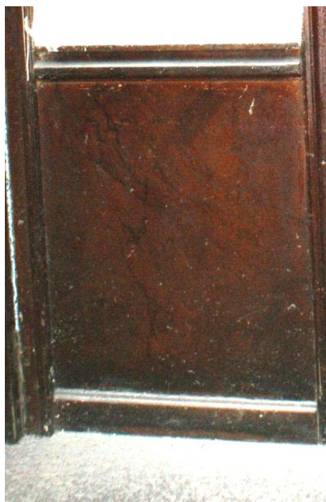
Εικόνα 18. Πασαμέντο με τεχνική απομίμησης μαρμάρου.
