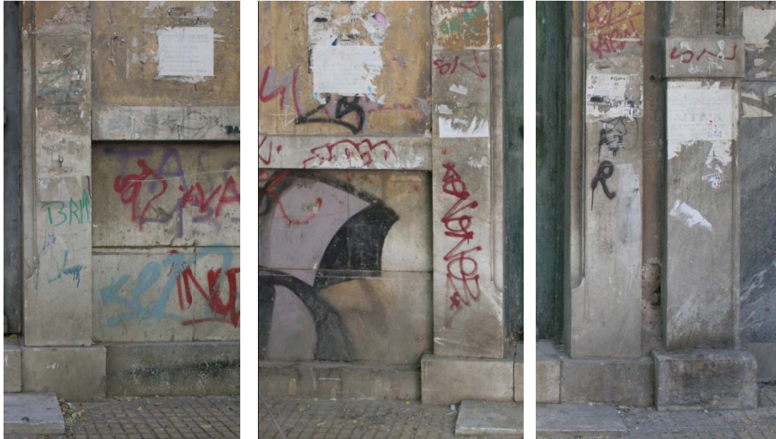
Εικόνα 201,202,203. Μαρμαρίνη επένδυση της βάσης του κτηρίου στην ανατολική κύρια όψη, λεπτομέρεια.
