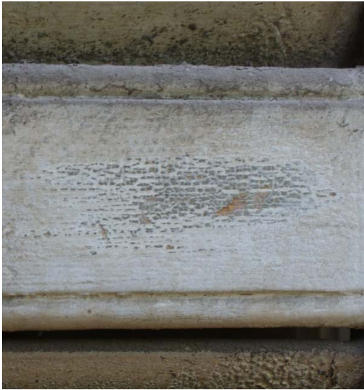
Εικόνα 94. Διερευνητική τομή σε πατζούρι για να διαπιστωθεί ο αρχικός χρωματισμός του.
