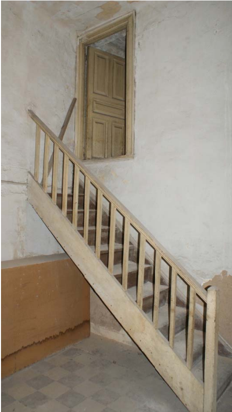
Εικόνα 64. Σκάλα που οδηγεί στο πατάρι του ισογείου μέσω της κουζίνας.
