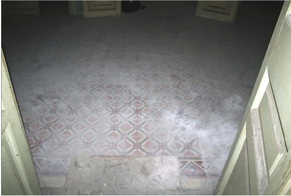
Εικόνα 143. Ισόγεια στάθμη - Χώρος ΙΣ.6.
