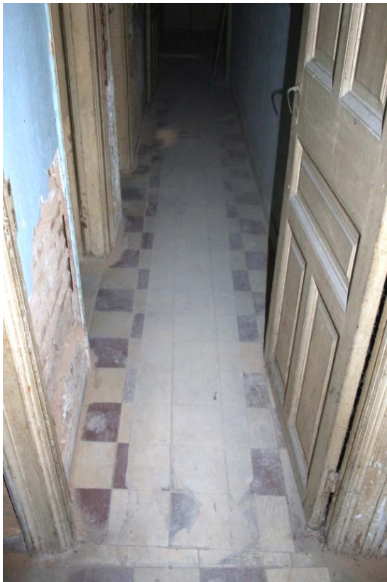
Εικόνα 167. Μεταγενέστερη επίστρωση του δαπέδου του χώρου ΙΣ.9 με πλαστικό.
