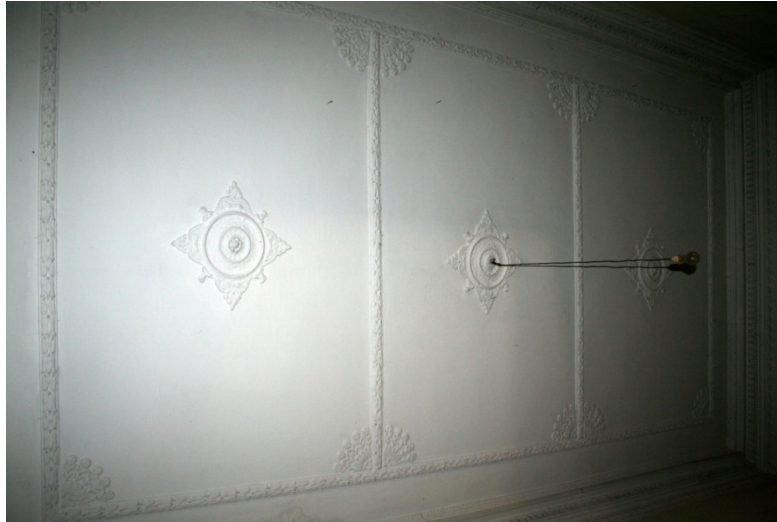
Εικόνα 107. Ισόγεια στάθμη - Χώρος ΙΣ.6.
