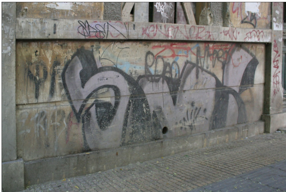
Εικόνα 192,193. Μαρμάρινη επένδυση της βάσης του κτηρίου στην ανατολική κύρια όψη.
