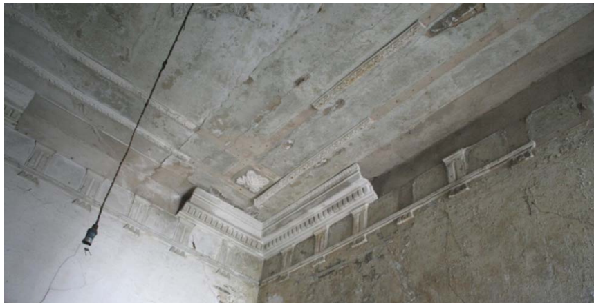
Εικόνα 132. Αποκολλήσεις τμημάτων του διακόσμου.
