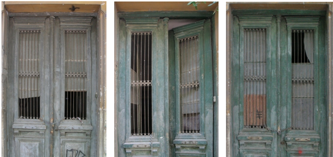
Εικόνα 176,177,178. Προστατευτικά σιδηρά κιγκλιδώματα στους υαλοπίνακες των θυρών εισόδου στην ισόγεια στάθμη.
