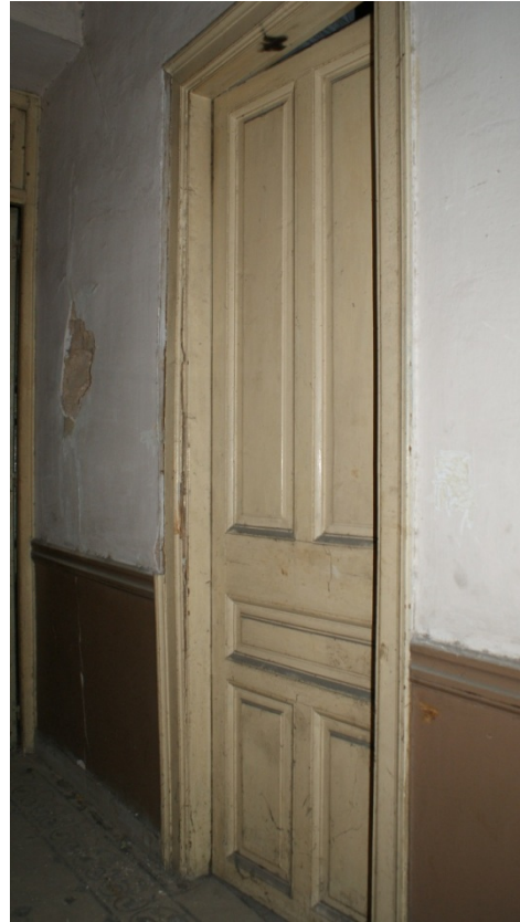
Εικόνα 88. Ξύλινη Ταμπλαδωτή Θύρα.
