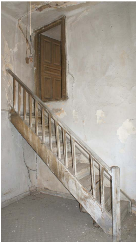
Εικόνα 66. Σκάλα που οδηγεί στο πατάρι του β' ορόφου μέσω της κουζίνας.
