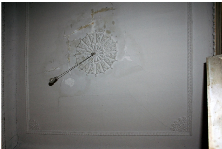
Εικόνα 103. Ισόγεια στάθμη - Χώρος ΙΣ.2.
