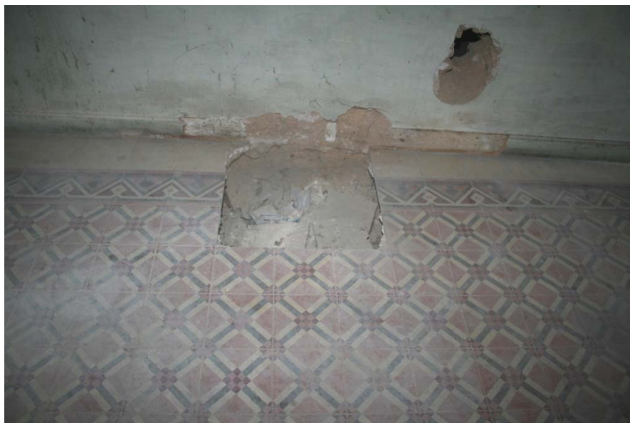
Εικόνα 170. Αποκόλληση πλακιδίων κατά τη διενέργεια ερευνητικών τομών.
