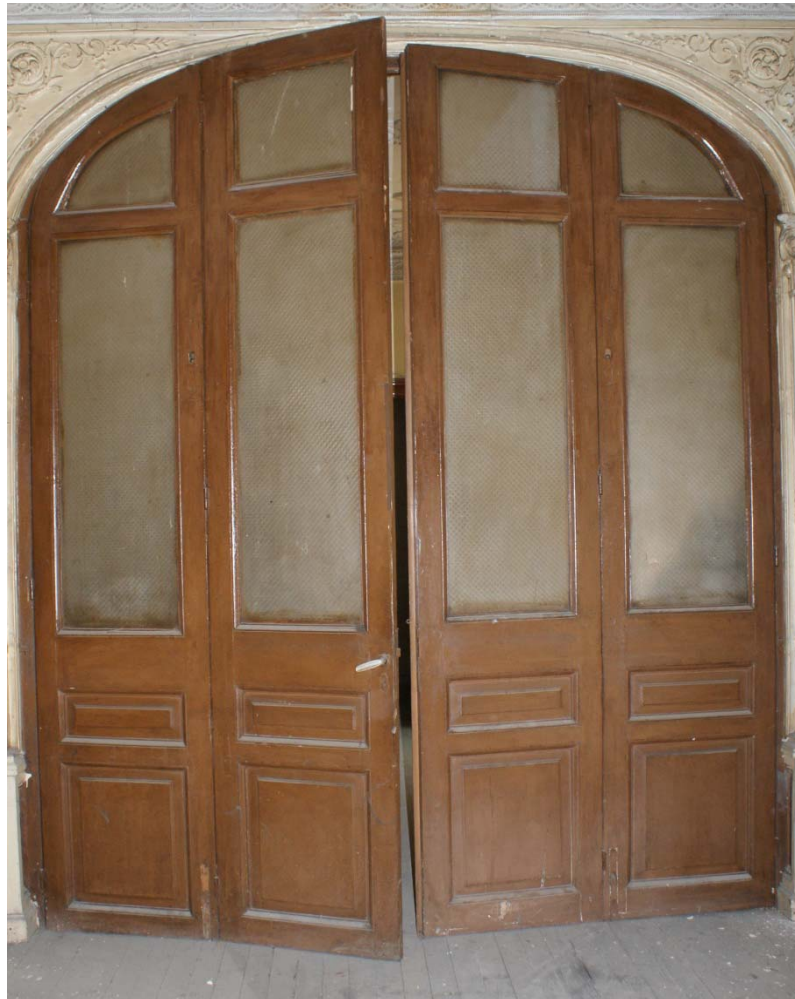
Εικόνα 83. Τετράφυλλη ξύλινη θύρα στον α' όροφο.
