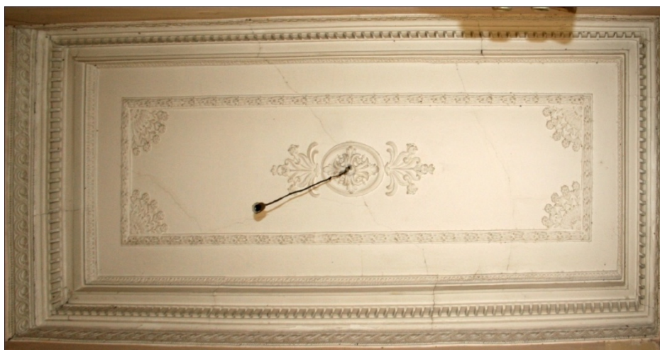
Εικόνα 104. Ισόγεια στάθμη - Χώρος ΙΣ.3.
